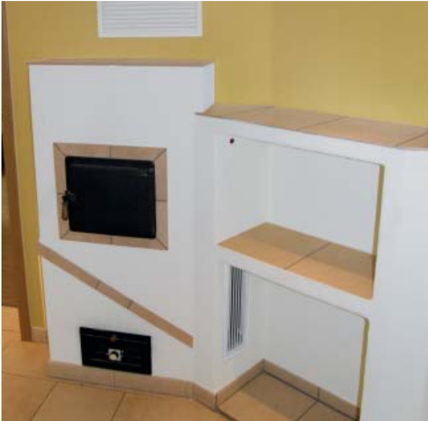
Bild 2 | Der Ofen vom Flur aus betrachtet; von hier wurde das Brennmaterial eingebracht.
