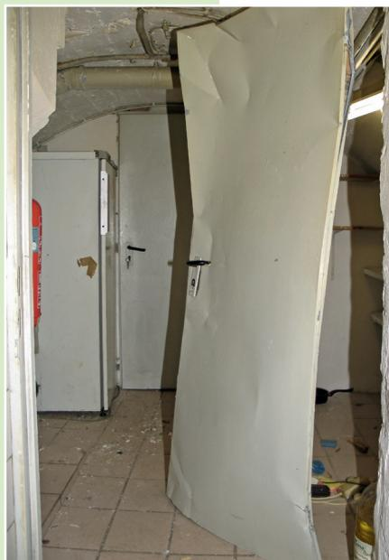
**Bild 4** | Durch die Druckwelle der Explosion deformierte Tür.
