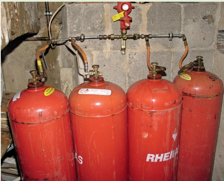
**Bild 1** | Gasflaschenlager abseits der Küche.
