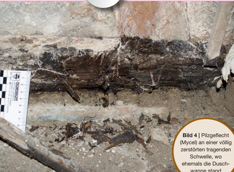
**Bild 4 | Pilzgeflecht (Mycel) an einer völlig zerstörten tragenden Schwelle, wo ehemals die Duschwanne stand**
