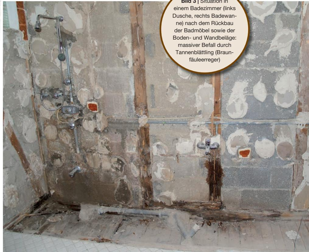
**Bild 3** | Situation in einem Badezimmer (links Dusche, rechts Badewanne) nach dem Rückbau der Badmöbel sowie der Boden- und Wandbeläge: massiver Befall durch Tannenblätling (Braunfäuleerreger)
