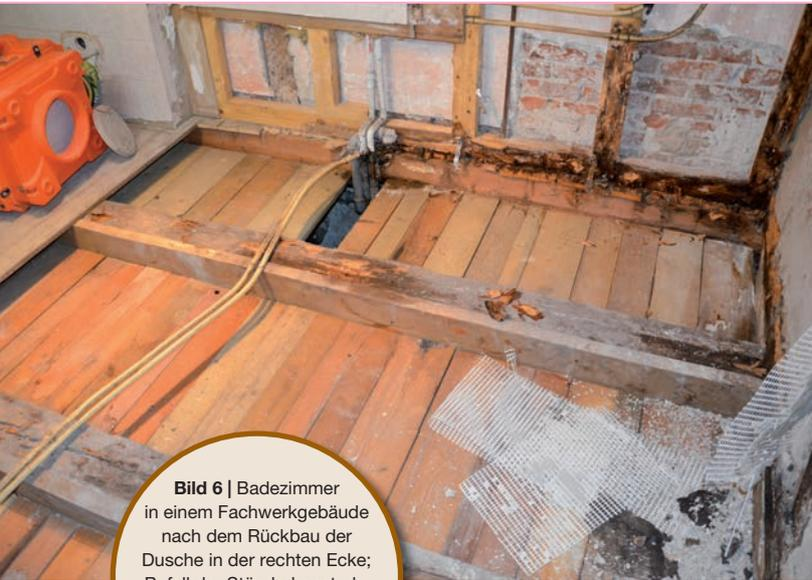
**Bild 6** | Badezimmer in einem Fachwerkgebäude nach dem Rückbau der Dusche in der rechten Ecke; Befall der Ständerkonstruktion sowie des eigentlichen Tragwerks durch den Stachelsporling (Weißfäuleerreger)
