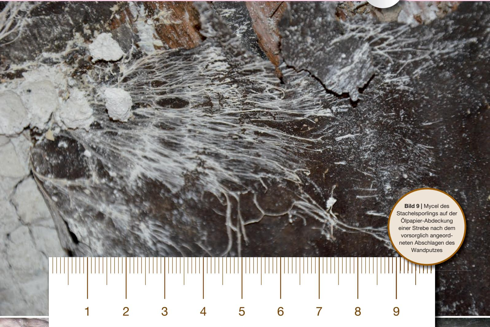
**Bild 9** | Mycel des Stachelsporlings auf der Ölpapier-Abdeckung einer Strebe nach dem vorsorglich angeordneten Abschlagen des Wandputzes
