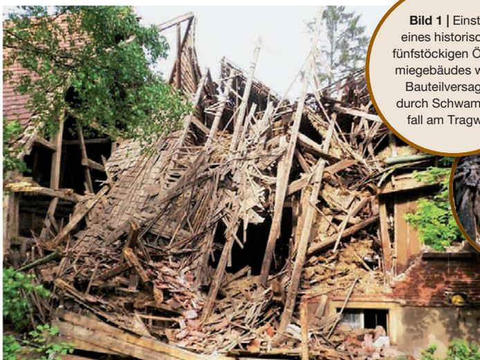
**Bild 1** | Einsturz eines historischen, fünfstöckigen Ökonomiegebäudes wegen Bauteilversagens durch Schwammbefall am Tragwerk
