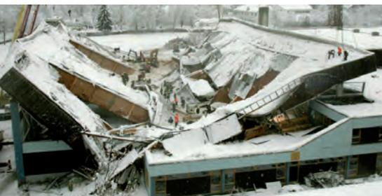
**Bild 1** | Aufgrund zu hoher Schneelasten eingebrochenes Dach der Eissporthalle in Bad Reichenhall 2006
