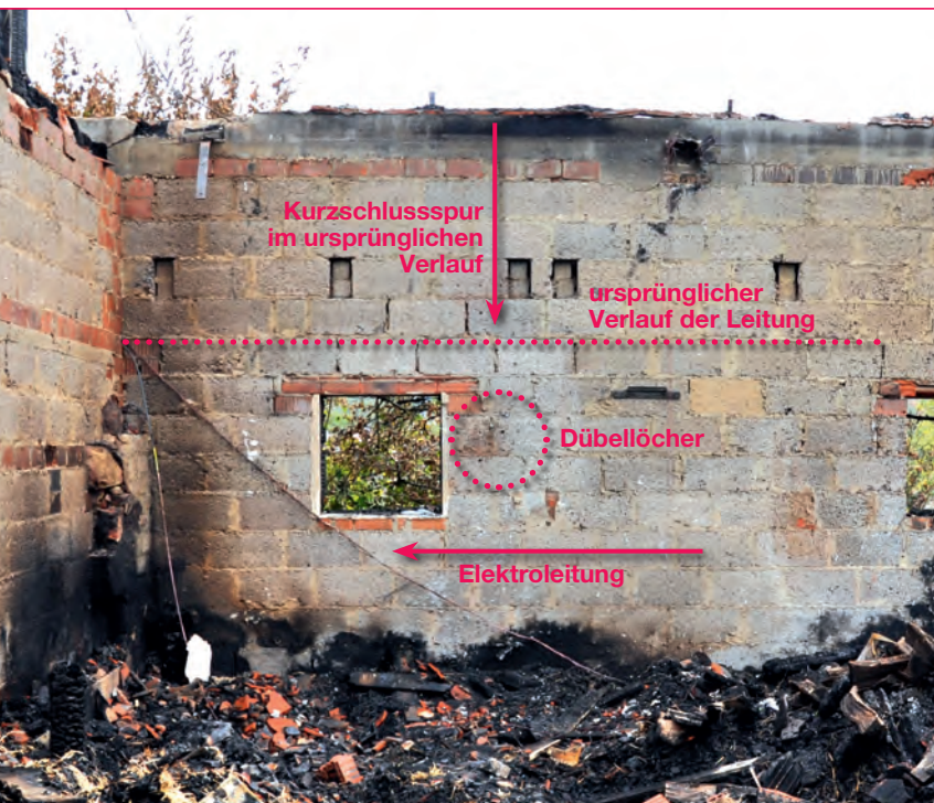
Bild 3 | Der Verlauf der Elektroleitung von einem Schaltschrank in der Scheune zu dem neben der Scheune befindlichen Einspeisepunkt ist hier eingezeichnet. Eine Kurzschlussspur in der Elektroleitung befand sich oberhalb zweier Dübellöcher.
