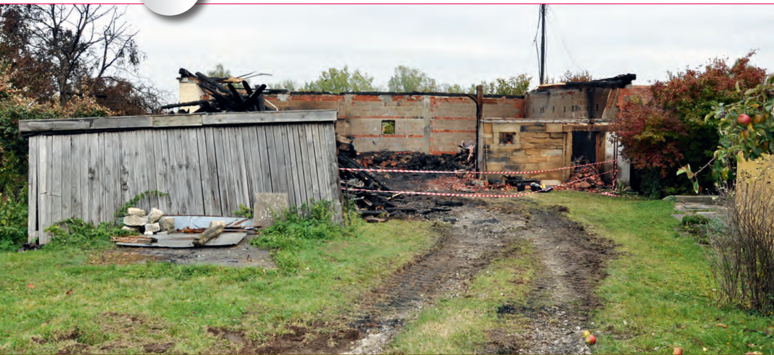
Bild 2 | Nach dem Brand waren nur noch die Mauern der ehemaligen Scheune erhalten. Das Dach, auf dem die Solarmodule installiert waren, musste wegen der Einsturzgefahr abgetragen werden.
