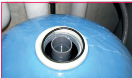
Bild 1 | Der untere Teil der grauen Kupplung befindet sich noch im Gewinde der Enthärterpatrone.
