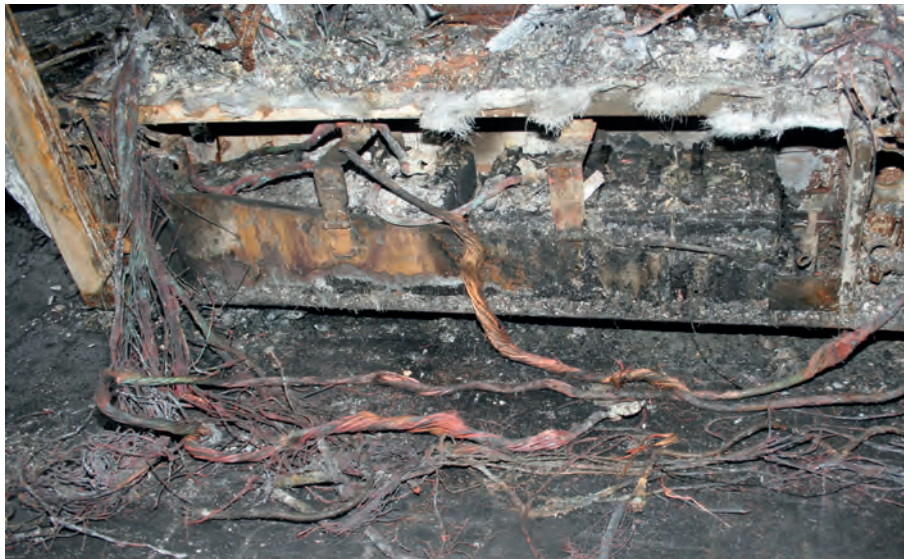
Bild 1 | Ausgebrannte Busabstellhalle (Quelle: IFS-Gutachten 1 )
