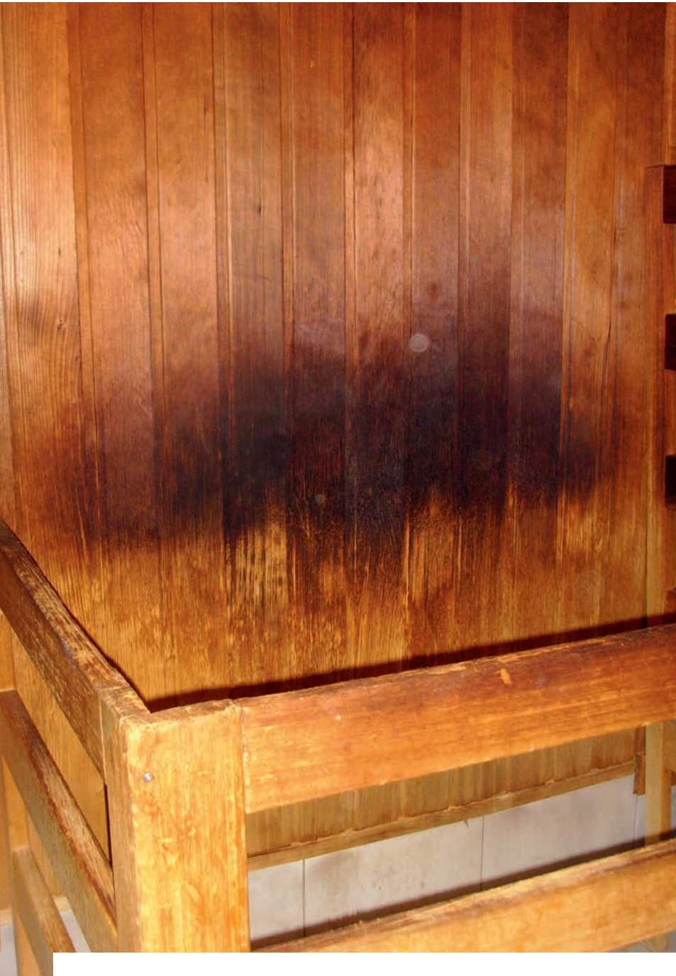
Bild 13 | Bei den gezeigten Verfärbungen am Holz einer Sauna handelt es sich nicht um Brandzehrungen bzw. um Spuren eines vorangegangenen Flammenbrands. Vielmehr handelt es sich hier um die typischen Verfärbungen infolge einer jahrelangen thermischen Aufbereitung durch den Betrieb des ursprünglich dort angebrachten Saunaofens.
