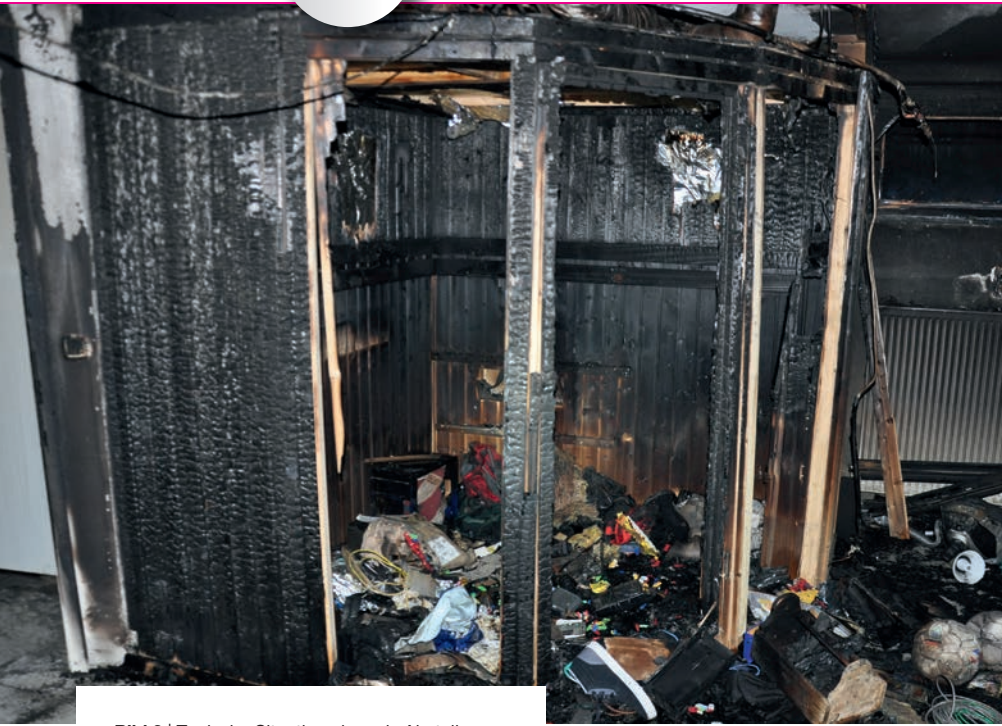
Bild 2 | Typische Situation einer als Abstellraum verwendeten Sauna im Keller eines Wohngebäudes
