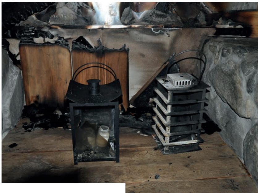
Bild 10 | Von Gästen in einer Sauna brennend zurückgelassene Kerzen in Laternen führten zu einem lokalen Brandgeschehen in einer Sauna einer Themenanlage.
