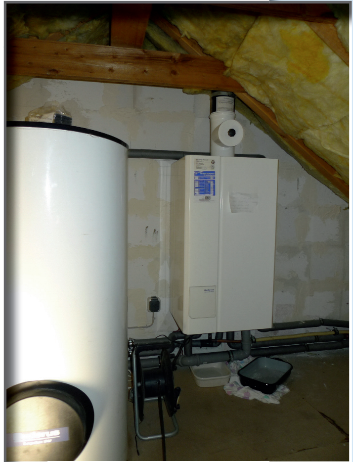
Bild 1 | Die Heizungsanlage auf dem Dachboden: Links befindet sich der Warmwasserspeicher, hinten die Gastherme.
