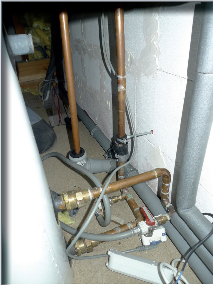
Bild 2 | In der Bildmitte ist die Trinkwasser-einspeisung zu sehen, an der sich die Leckage befand.
