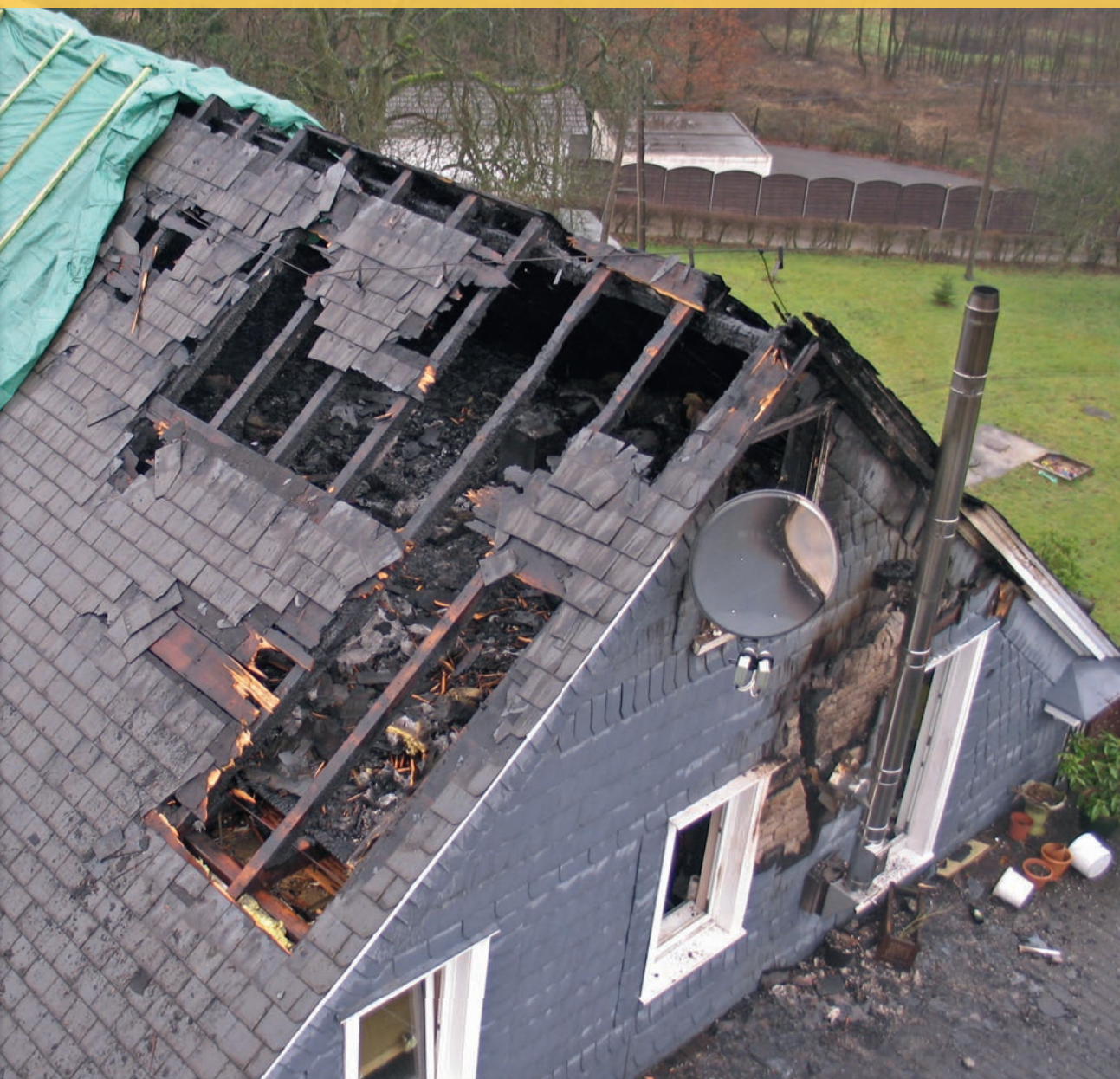
Bild 19 | An der Schadenstelle war nachzuvollziehen, dass der Brand seinen Ausgangspunkt an der Durchführung des Verbindungsstückes vom Kaminofen durch die Außenwand zum Schornsteinsystem genommen hatte.
