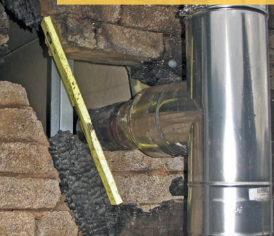
Bild 21 | Der Abstand eines senkrecht, leicht schräg verlaufenden Balkens zu dem Verbindungsstück betrug etwa 7 cm.
