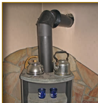
Bild 17 | Blick auf den Kaminofen im Wohnraum. Direkte Brandschäden liegen hier nicht vor.
