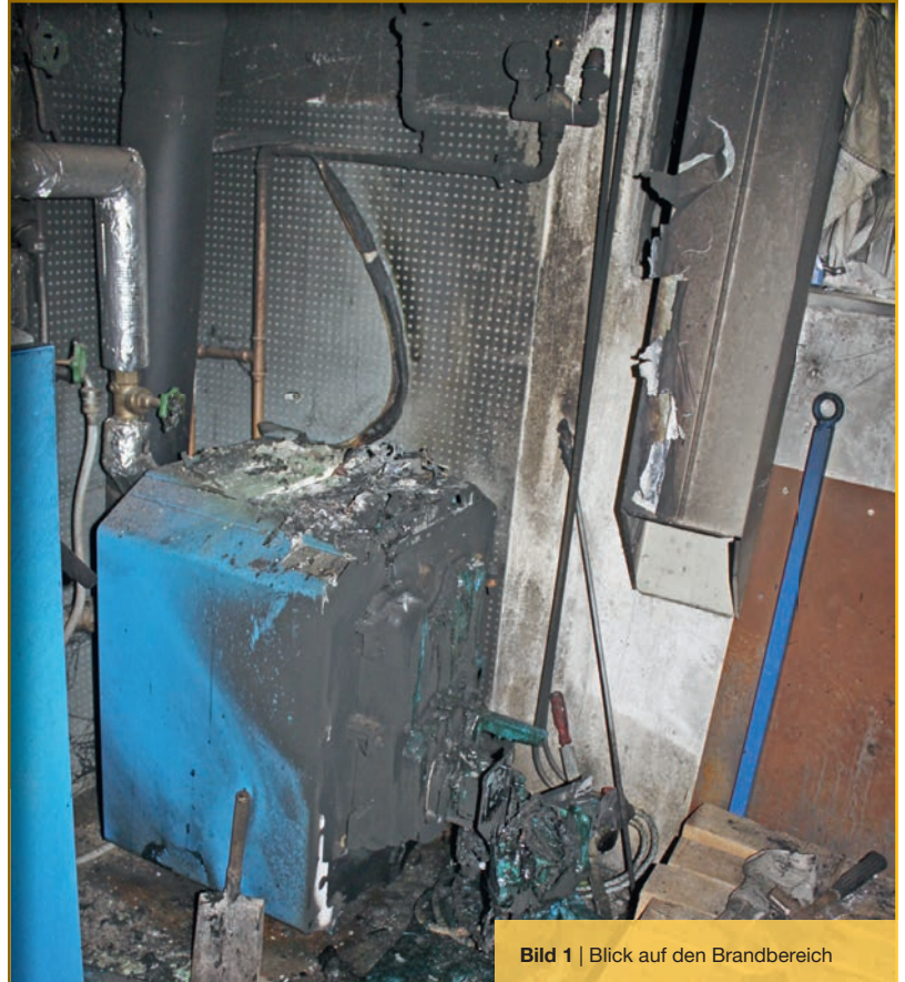
Bild 2 | Schadensschwerpunkt und Brandausbruchbereich an der Regelung des Ölheizkessels
