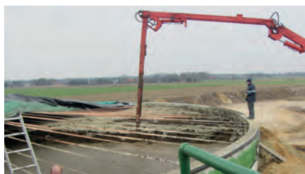
Bild 9 | Schwimmschichtbildung, die durch eine Rührwerkshavarie entstanden ist.
