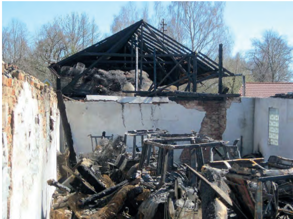
Bild 19 | Schaden durch Schlepper
