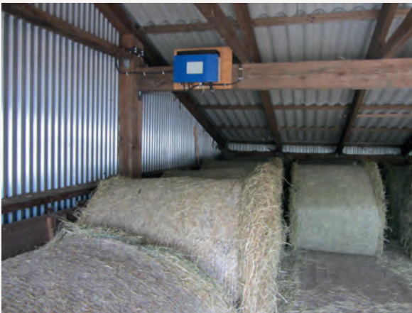
Bild 5 | Überbaute Blitzschutzanlage
