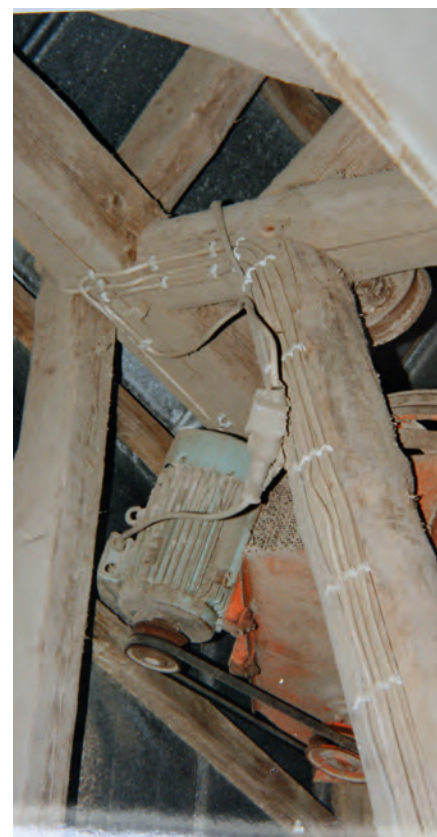
Bild 20 | Motor mit starken Staubablagerungen
