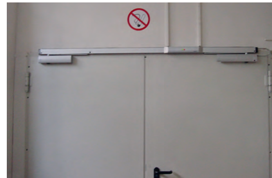
Bild 8 | Feuerschutzabschluss mit integrierter Feststellanlage
