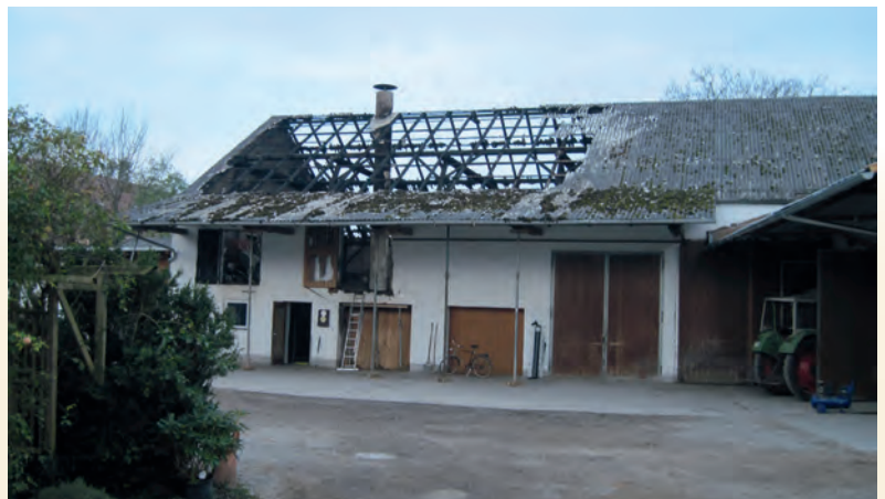
Bild 3 | Aufgrund der feuerwiderstandsfähigen Decke konnten die Tiere im Erdgeschoss unverfehrt gerettet werden.
