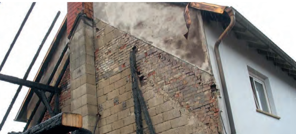
Bild 7 | Brandwand hat ihren Zweck erfüllt
