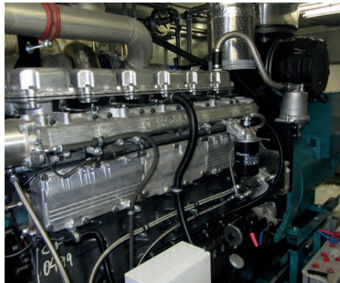
Bild 4 | Zündstrahlmotor, der speziell für den Zündstrahlbetrieb entwickelt wurde
