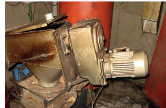
Bild 2 | Brand in einem Technikraum durch heiß gelaufenen Pellets-Antrieb
