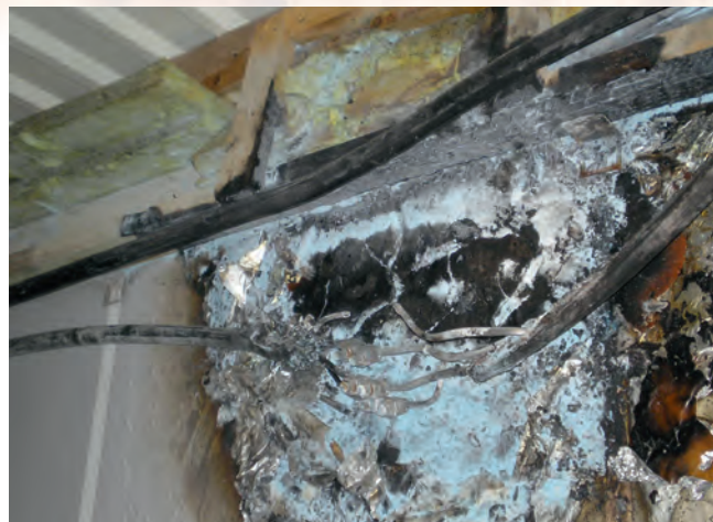
Bild 1 | Brandschaden durch mangelhafte Klemmverbindung
