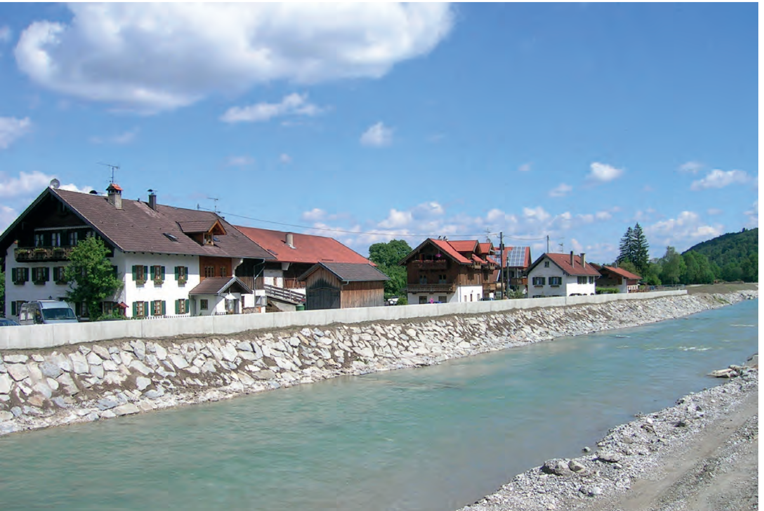
Bild 26 | Damm für den Hochwasserschutz
