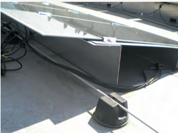
Bild 5 | Überbaute Blitzschutzanlage
