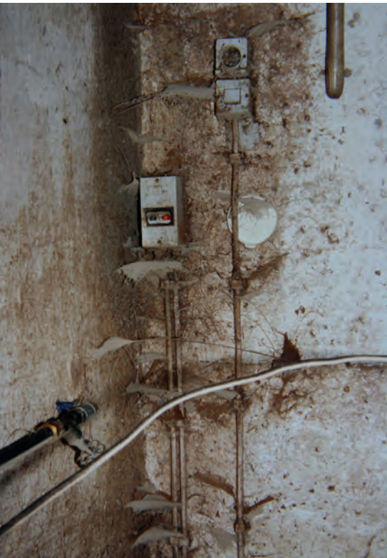
Bild 12 | Verlegung Elektroleitungen
