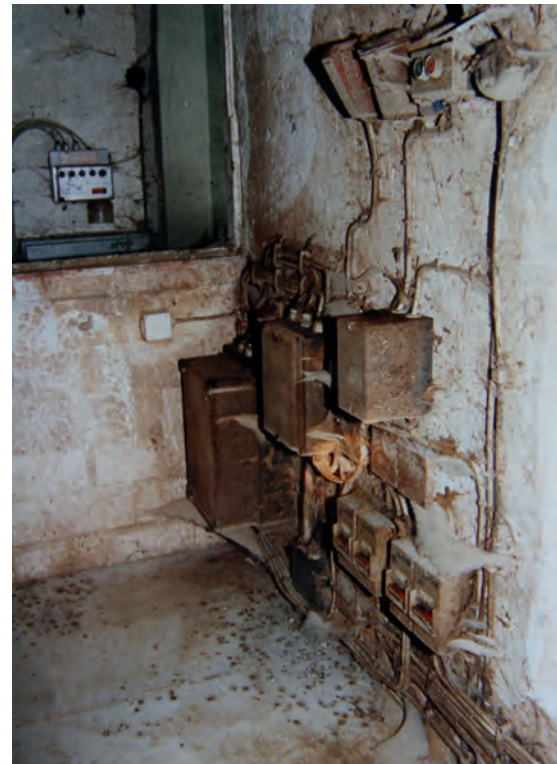
Bild 11 | Stark verschmutzte und verstaubte Elektroinstallation
