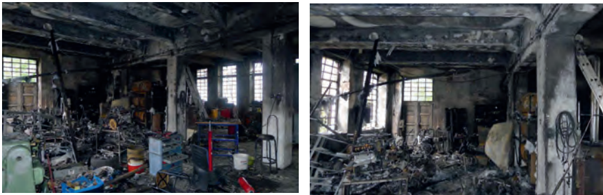
Bild 17 a und b | Schweißarbeiten führten zum Abbrand der Werkstatt
