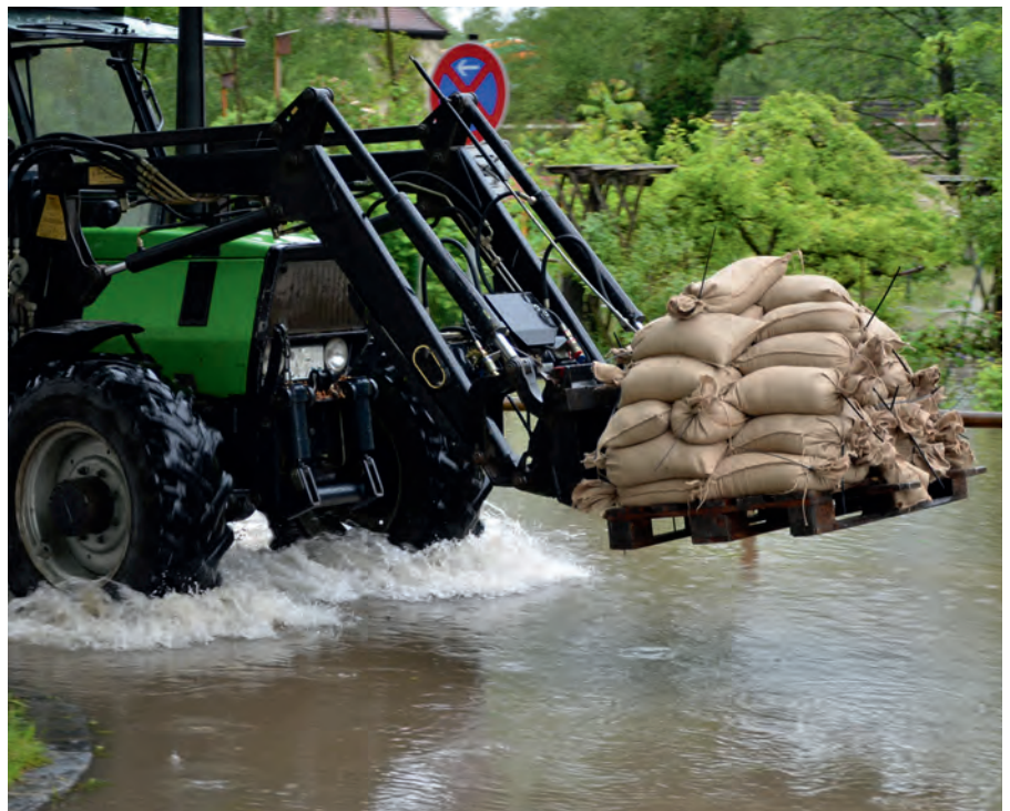
Bild 25 | Abdichtung mit Sandsäcken
