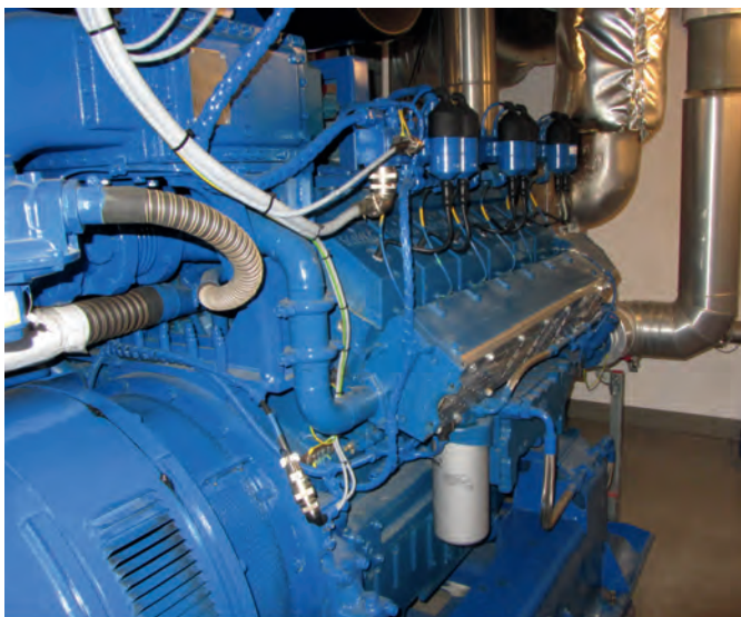
Bild 5 | Gasmotor mit einer Leistung von 400 kW
