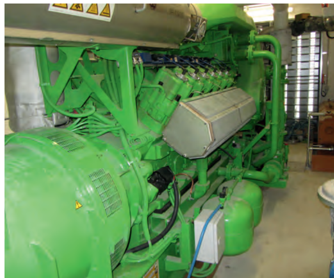
Bild 6 | Gasmotor mit einer Leistung von 500 kW
