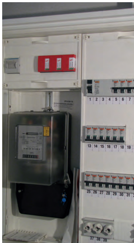
Bild 13 a und b | Sauber ausgeführte Elektroverteilung, Quelle: DEHN + Söhne GmbH
