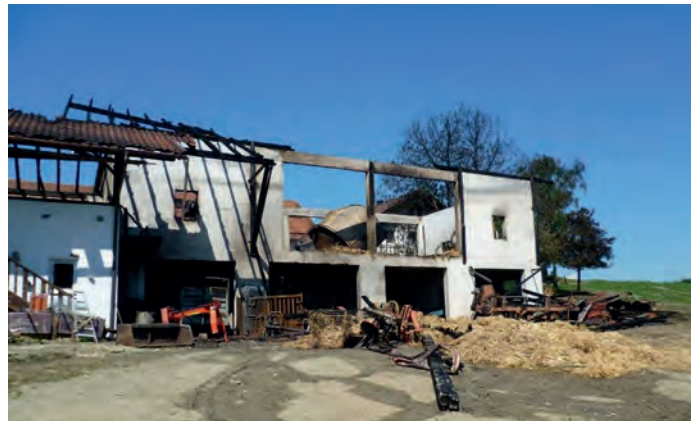
Bild 22 | Schaden durch Selbstentzündung
