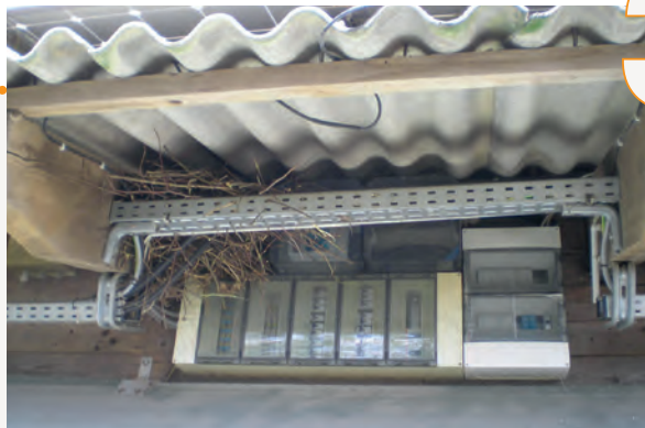
Bild 9 | Vogelnest auf Verteilung und Kabelbühne
