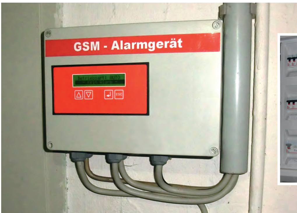
Bild 6 | Alarmgerät mit eingebauter telefonischen Weiterleitung über das Handynetz, Quelle:alcona Automation
