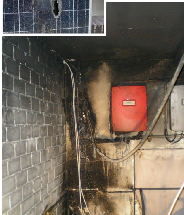
Bild 2 | Lichtbogenschaden Bild 3 | Bauteilversagen in der Wechselrichterverteilung
