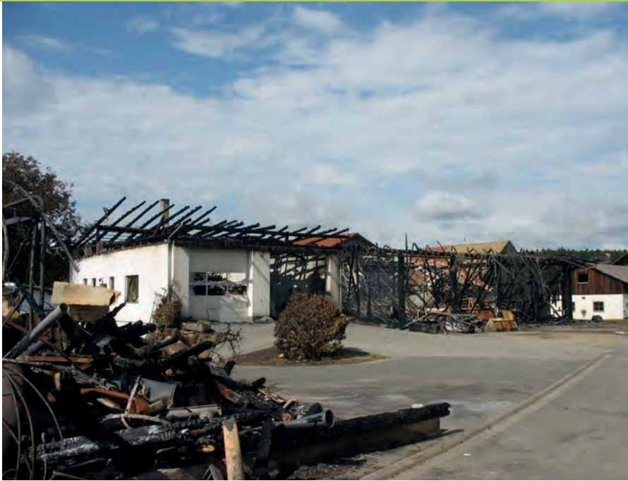
Bild 1 | 530.000,- € Schaden durch Blitzschlag
