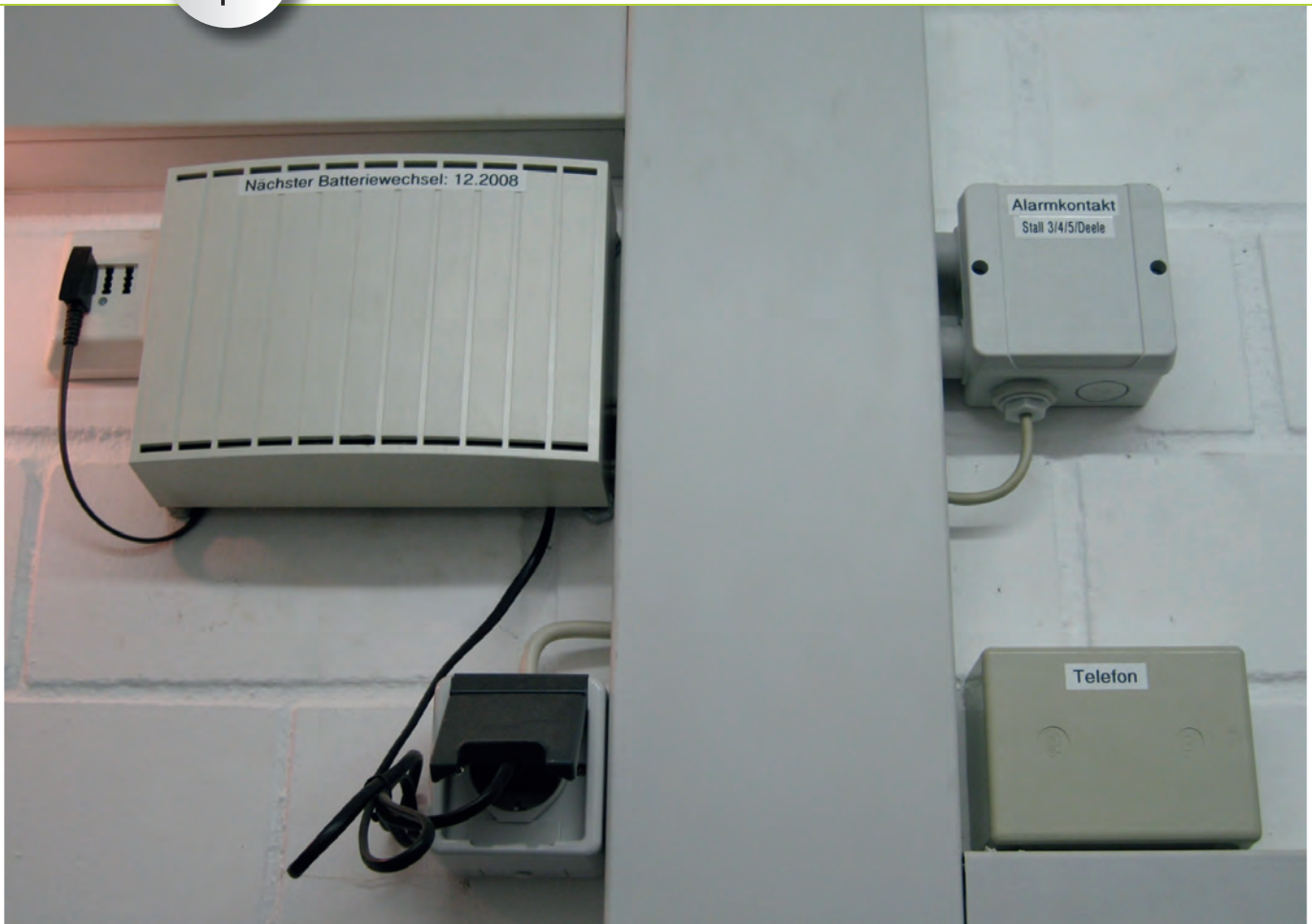
Bild 5 | Telefonwählgerät als Teil der Alarmierungskette, Quelle: Westfälische Provinzial Versicherung AG
