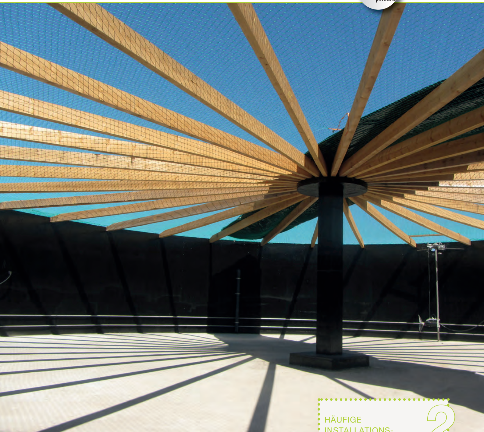
Bild 10 | Innenansicht eines typischen Behälters mit „Aufputz-Beheizung“
