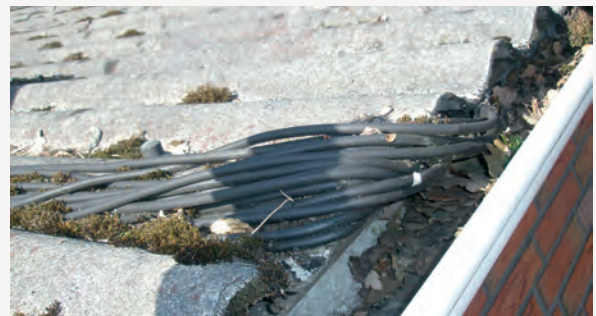
Bild 6 – 8 | Nicht fachgerechte Kabelführung
