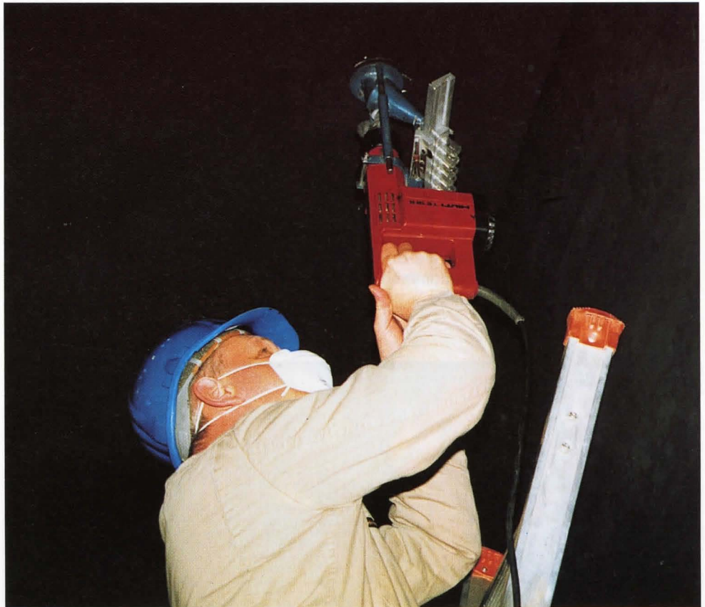
Abb. 11: Probenahme mit einer Schlagbohrmaschine mit spezieller Vor- richtung zur Entnahme von geschichteten Bohrmehlproben aus Stahlbeton
