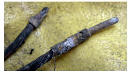
Bild 13 | Reste zweier Steckverbinder aus dem Schutt eines Wohnhauses. Der rechte Stecker war in Ordnung, der linke ist durch einen Lichtbogen stark beschädigt worden. Der Kontaktstift ist verdampft, die Crimpung ist noch teilweise erhalten. (Foto: IFS)
