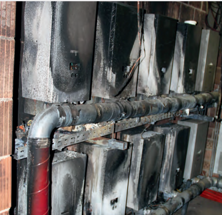
Bild 15 | Technikraum einer PV-Anlage nach einem Brand
