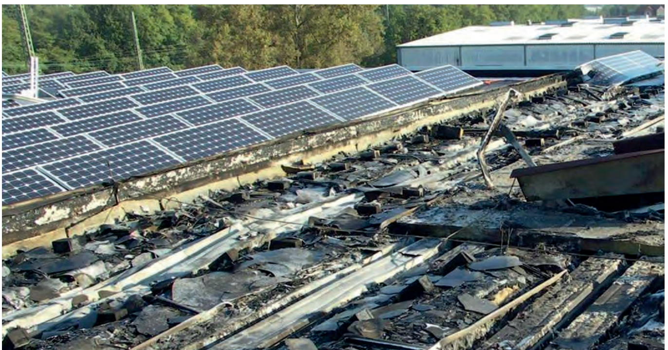
Bild 11 | Brand einer PV-Anlage auf einem Flachdach. Der Gutachter fand Modulreste, die schlechte Lötverbindungen als Ursache sehr wahrscheinlich machen. (Foto: W. Rütz)
