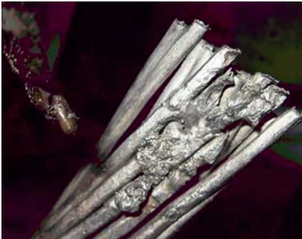
Bild 18 | Geschmolzenes Aluminium aus einer losen Klemmstelle. Da Aluminium bei niedrigen Temperaturen schmilzt, führen Kontaktwiderstände früher als bei Kupfer zum Auftrennen des Leiters und damit zum Lichtbogen. (Foto: Uli Motzer, Württembergische Versicherung)
