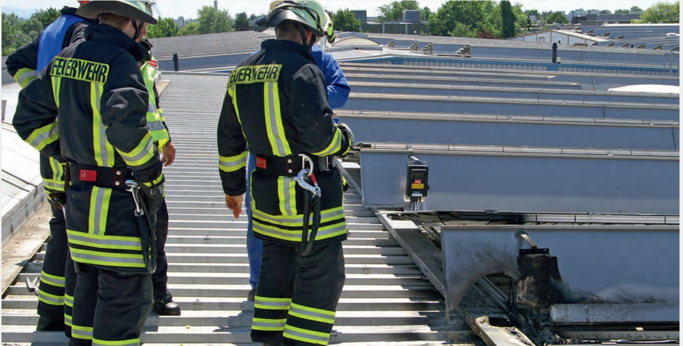
Bild 14 | Brand Generatoranschlusskasten. Exponierter DC-Verteiler; Überhitzung, Schalter versagte und löste Lichtbogen aus! (Foto: Freiwillige Feuerwehr Bühl)
