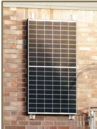
Bild 4 / Wandmontage eines PV-Moduls
