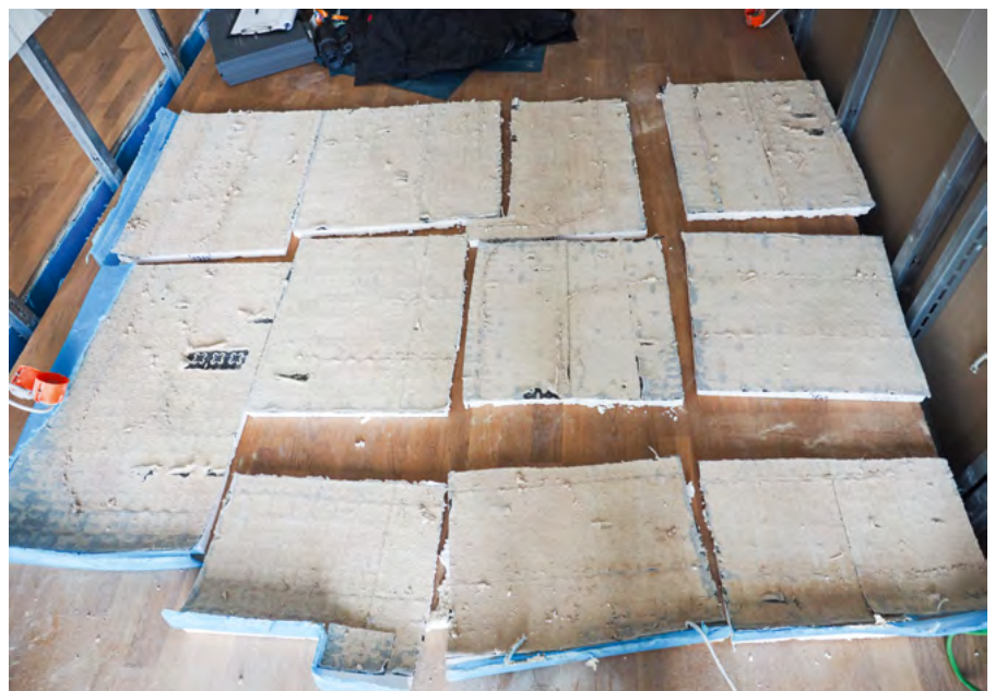
Bild 2 / Die Estrichdämmschichten wurden in Blöcken herausgeschnitten.
