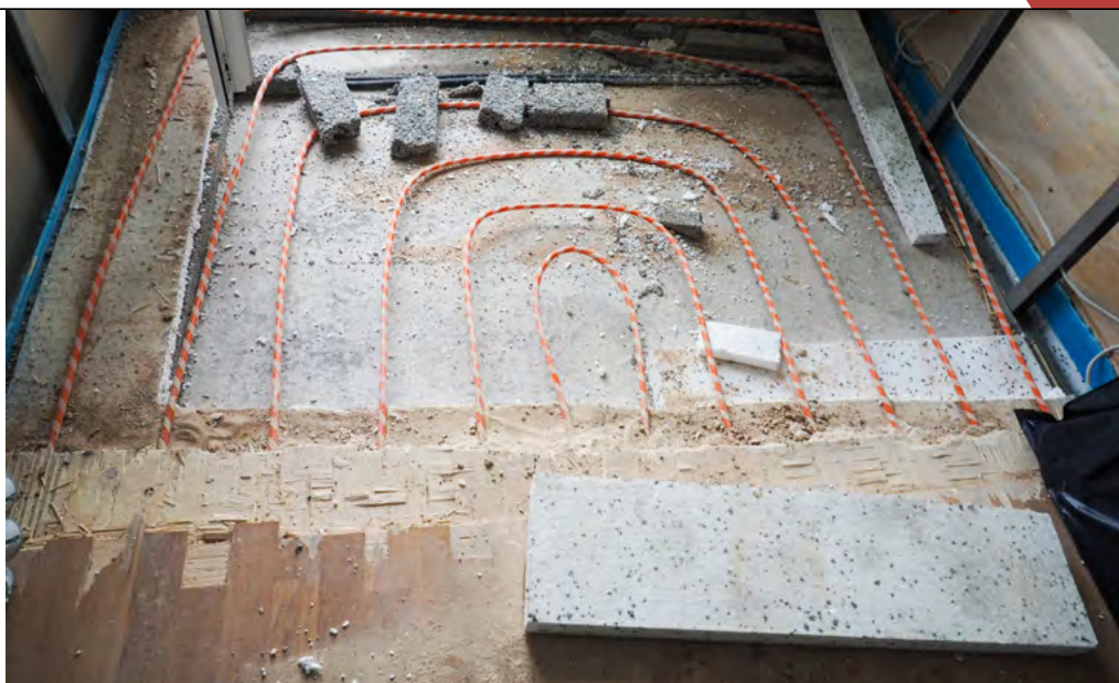
Bild 3 / Blick auf die Fußbodenheizung und die darunter liegende Betonplatte nach Entnahme der Estrichdämmschichten
