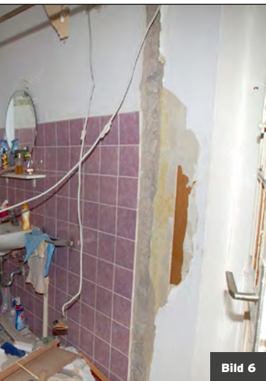
Bild 6 / Blick vom Flur in das Badezimmer: Neben der vollständig herausgebrochenen Flurwand wurde auch die Außenwand strukturell zerstört. Der Heizstrahler (Markierung), auf dem die Treibgasdose lag, ist aus der Verankerung gerissen. Die Flugbahn der geborstenen Dose ließ sich anhand des Einschlags des Dosenbodens in den Wandputz (Pfeil) rekonstruieren. Bild 7 und 8 / Die für die Explosion verantwortliche Insektiziddose wies einen durch den Überdruck abgerissenen Kopf (1) auf. In der Folge wurde der Grundkörper beim schlagartigen Austreten des Treibgases so weit beschleunigt, dass der Boden der Treibgasdose (2) in den Wandputz der angrenzenden Seitenwand einschlug und dort massiv zusammengestaucht wurde.
