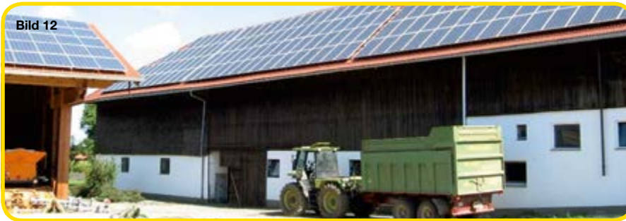
Bild 12 | PV-Anlagen sind auf den Dächern der meisten landwirtschaftlichen Betriebe installiert
