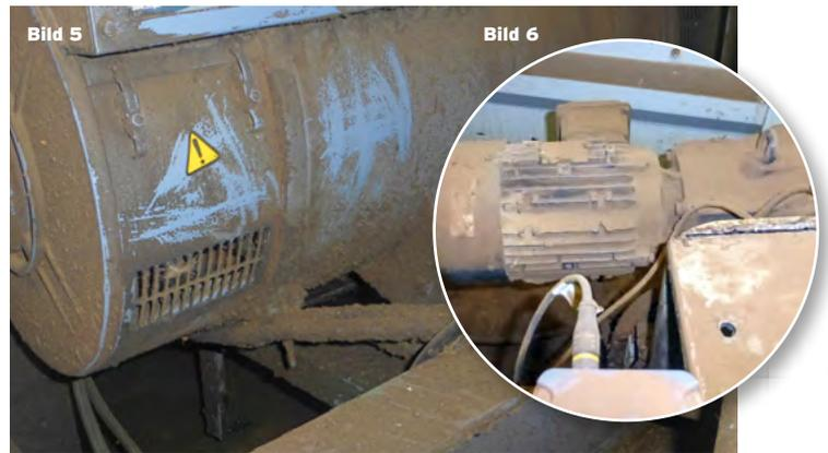
**Bild 5** / Ungefilterte Zuluft verschmutzt nicht nur den Aufstellraum, sondern über die Lüftungsöffnungen auch die Generatorwicklungen; Folge: vorzeitiger Ausfall.
