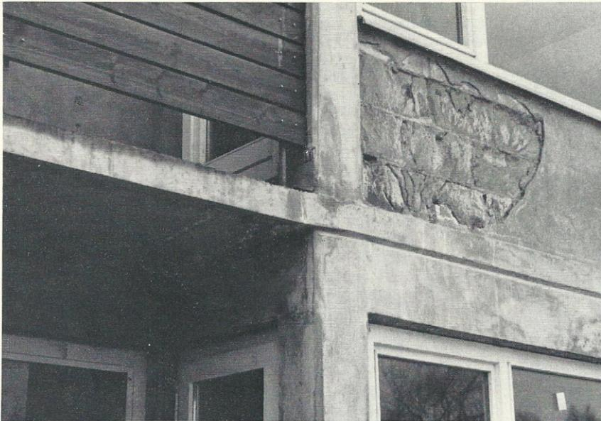
Abb. 4. Frostschäden am Gasbetonbrüstungsmauerwerk. Die Atmungsaktivität des Mauerwerkes wurde durch einen „dampfdichten“ Dispersionsbinderanstrich gestört. Derartige Anstriche sollten erst nach Austrocknung des Baues hergestellt werden.
