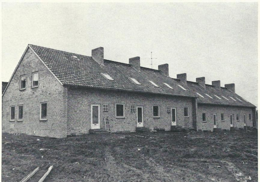
Abb. 5. Dieses Gebäude wurde durch Frostbildung unterhalb der Fundamente (trotz Hinterfüllung) angehoben und stark beschädigt.
