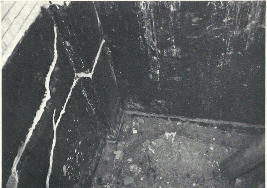
Abb. 6. Die Hinterfüllung mußte wieder ausgehoben, das Mauerwerk ausgebessert bzw. erneuert und die Gebäudeisolierung in schwieriger Arbeit wiederholt werden.
