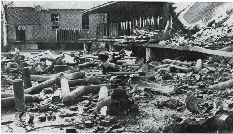
Bild 1. Auswirkungen einer Acetylenexplosion in einem Acetylen-Füllwerk.
