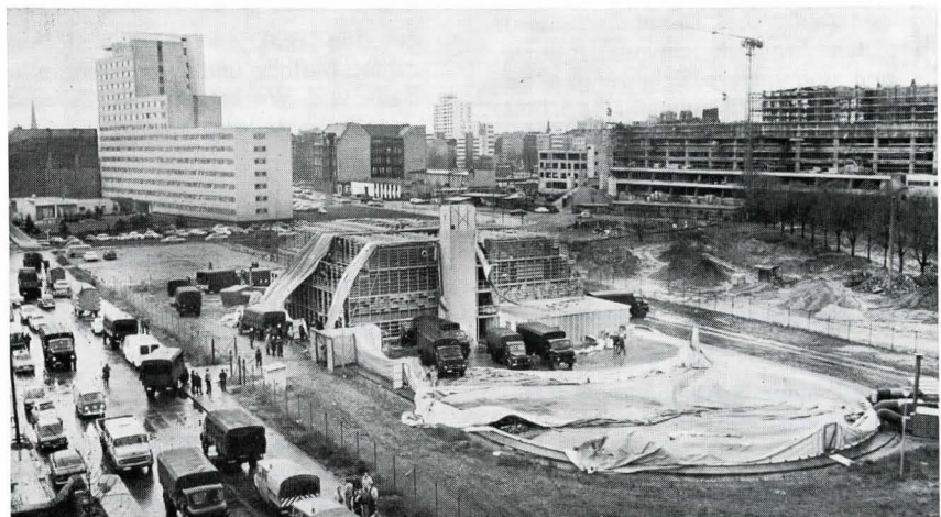
Bild 2. Die gleiche Traglufthalle nach der Zerstörung durch den Orkan am 13. November 1972. (Fotos: Ullstein-Bilderdienst)
