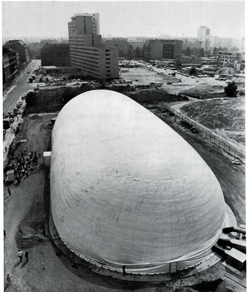
Bild 1. Traglufthalle über den Rohbau der neuen Staatsbibliothek in Berlin. Darin lagerten Bücher im Werte von 1 Million DM.
