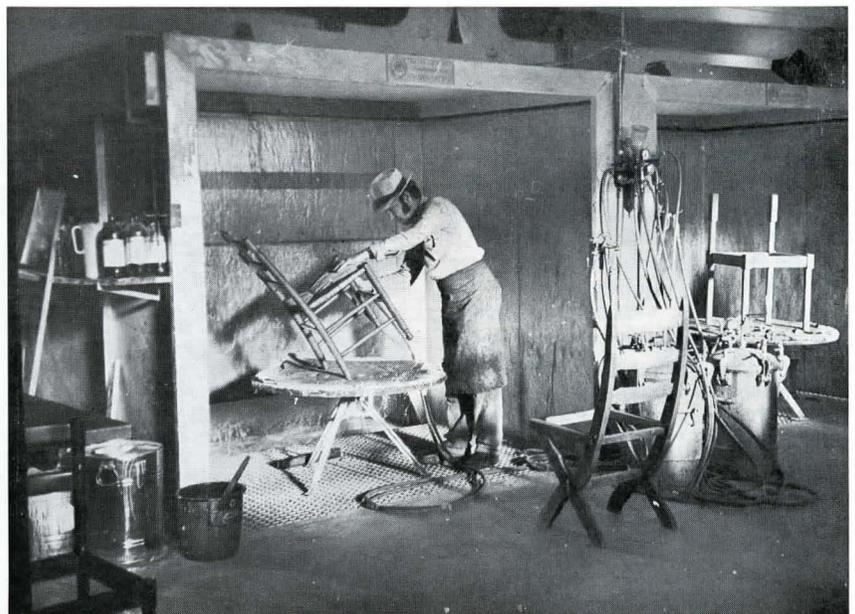
Bild 10. Moderne Spritzkabine mit Wasserberieselung an Rückwand und an Seitenwänden.
