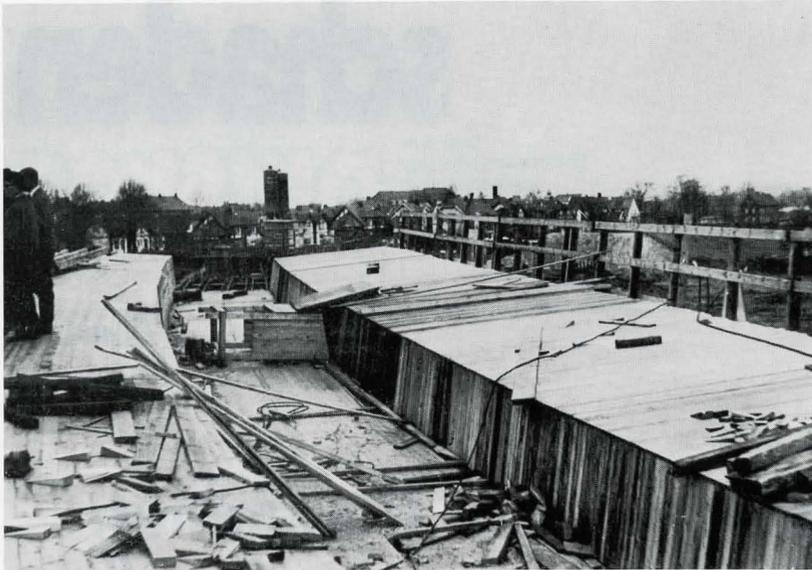
Bild 2. Orkanartige Stürme beschädigten die handwerksgerecht hergestellten Lehrgerüste eines Brückenbauwerkes. Schadenhöhe ca. 48 000 DM.
