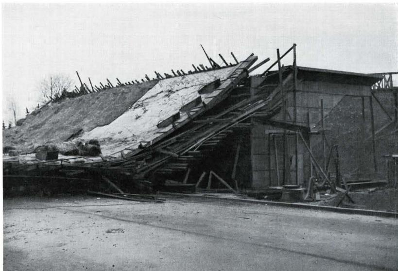
Bild 1. 6 Stunden nach der Betonschüttung stürzte das Brückenbauwerk ein. Ursache des Einsturzes: „ungewöhnliche Witterungseinflüsse“.
