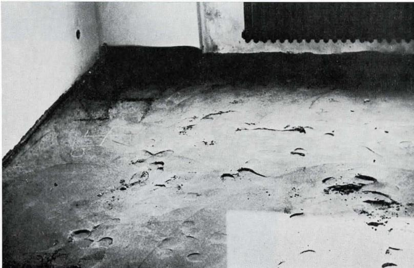
Bild 14. Unbekannte Täter zerstörten die Absperrung und beschädigten den schwimmenden Estrich in ganzer Ausdehnung des Erdgeschosses (Versicherungsfall).
