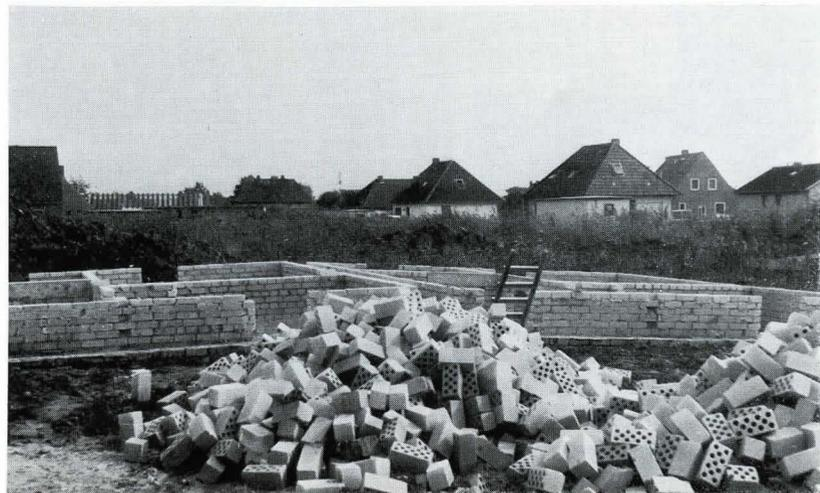
Bild 6. Sachverständige konnten ermitteln, daß der Keller in der Mitte hochgetrieben wurde. Fehler der Erfüllungsgehilfen bei der Wasserhaltung waren die Ursache.
