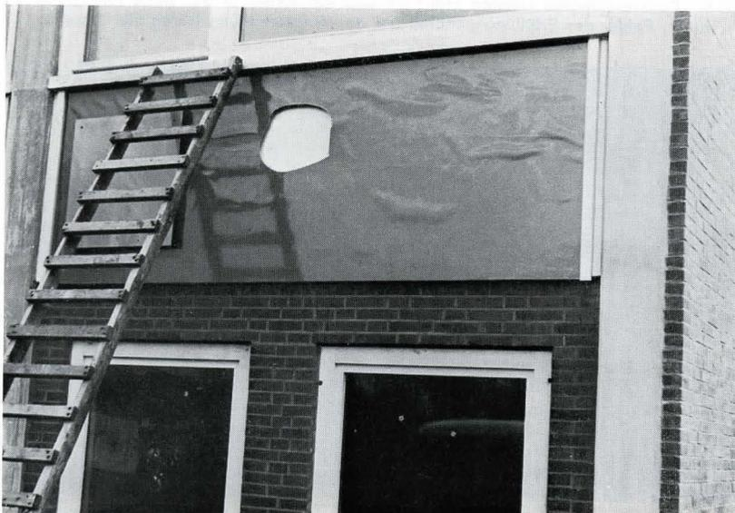
**Bild 10.** Kunststoffbeschichtete Holzfaserverplatten, die für Innenausbauten gut geeignet sind, wurden hier unzulässig als Brüstungselemente eingebaut.
