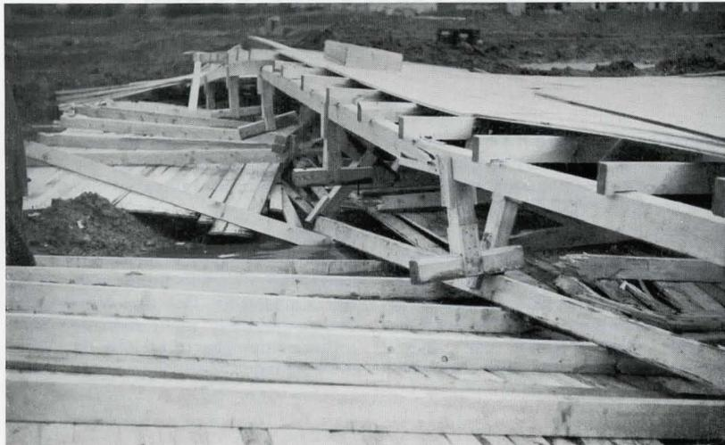
Bild 3. Die Schalungen wurden durch Sturm auf den Bahnkörper der Strecke Hamburg-Elmshorn geschleudert.
