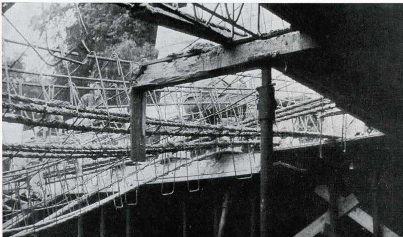
Bild 15. Deckeneinsturz in einem Bankneubau. Die Stützen der Stahlbetondecke im Mittelbereich gaben nach: Schadenhöhe ca. 15 000 DM (Technischer Fehler).
