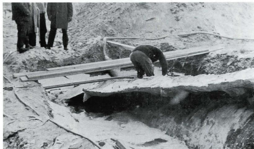
Bild 7. Immer wieder schwimmen Öltanks auf, weil gegen die anerkannten Regeln der Technik beim Einbau verstoßen wird. Für solche Verstöße wird der Bauwesenversicherer in aller Regel nicht aufkommen.
