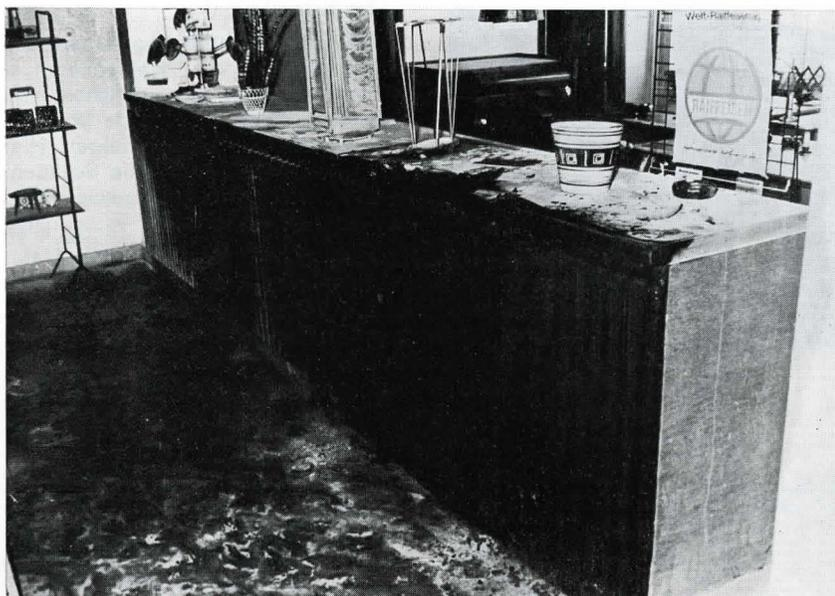
Bild 3. Flächenbrandschäden auf dem Fußboden.
