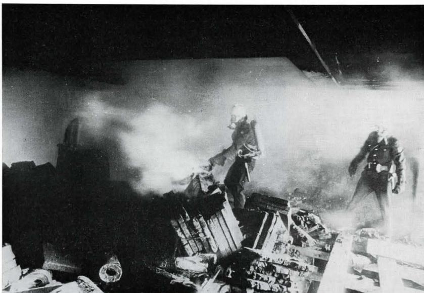
Bild 4. Baustelle Ernst-Reuter-Platz, Berlin. Auf dem Dach des Rohbau-Hochhauses brannten ca. 400 qm Bitumen-Isoliermaterial. Einspeisestelle und trockene Steigleitung für die Feuerwehr waren zu diesem Zeitpunkt noch nicht betriebsbereit.
