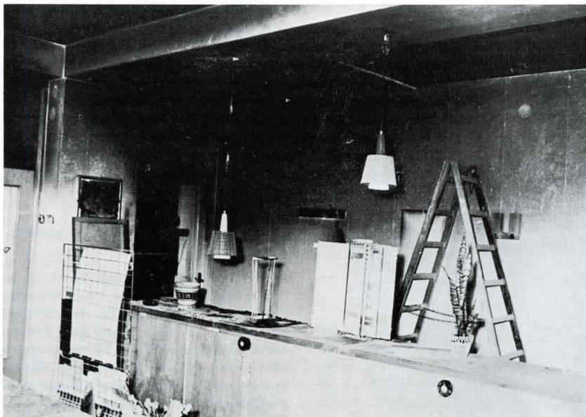
Bild 2. Rußablagerung an Decken und oberen Wandbereichen (Explosionsschwade).
