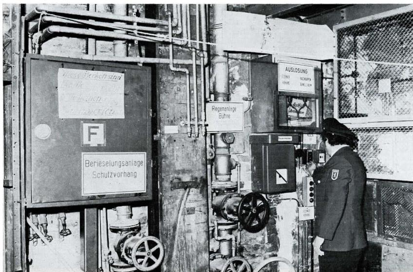
Bild 1. Betätigung der Sicherheitseinrichtungen (Feuermelder, Schutzvorhang, Rauchabzug, Regenanlage Bühne, Berieselungsanlage Schutzvorhang, Selbsthilfeeinrichtung Wandhydrant) von der Bühnenseite aus.
