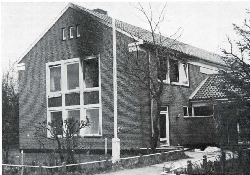
Bild 20. Folgen eines Brandschadens in einem Schulgebäude, ausgelöst durch einen nicht ausgeschalteten elektrischen Heißwasserbereiter ohne Temperaturschutz. Schadenhöhe: Ca. 80.000 DM.
