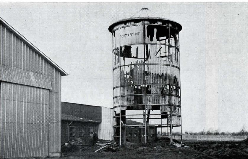
**Bild 6.** Durch einen Lichtbogenkurzschluß an einer Kraftstromleitung gerieten die Ernteezeugnisse eines landwirtschaftlichen Betriebes in Brand.
