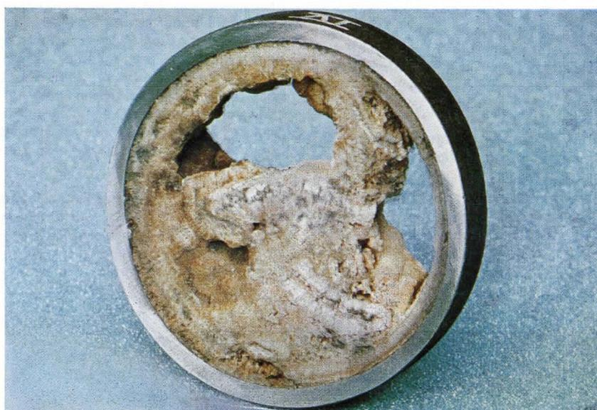
Bild 12. Steinbildung in einem Warmwasserrohr.
