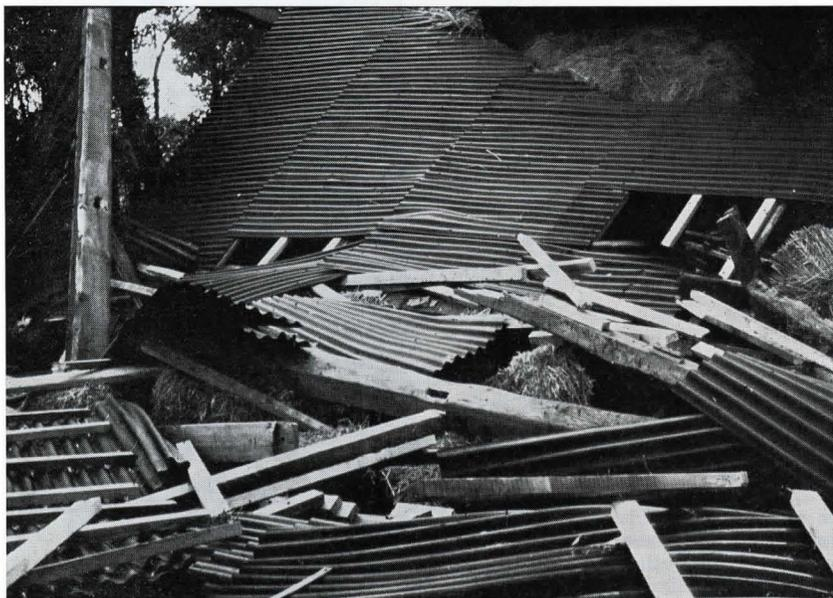
Die Scheune wurde durch die Sogwirkung einer starken Bö angehoben und zum Einsturz gebracht.
