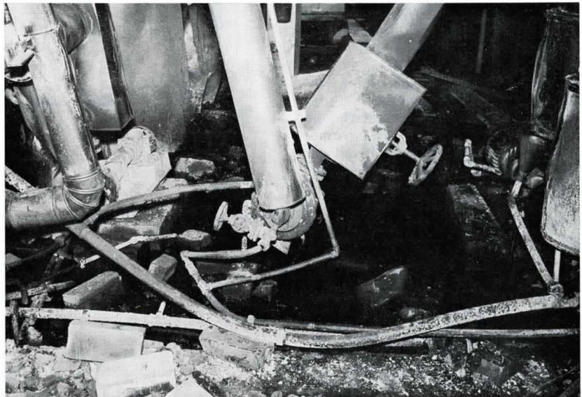
Bild 9. Blick auf die zerstörten Ölpumpen.
