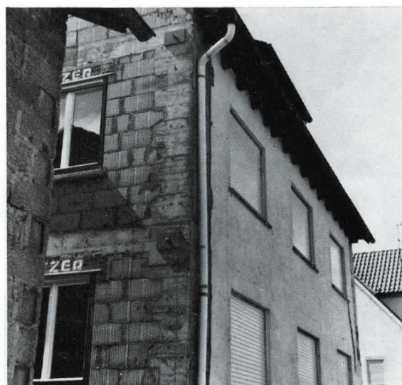
Bild 10. In den Fällen, wo beide nichttragende Giebelwände abgetragen werden mußten, wurden die beiden neu aufgeführten Giebelwände durch Zuganker verbunden, um so dem ganzen Gebäude wieder einen inneren Zusammenhalt zu geben. Man beachte die Ankerplatte für die Stahlzuganker in Deckenhöhe.
