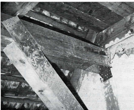
Bild 3. Knotenpunktaussteifung eines Dachstuhles – nach dem Erdbeben – mit H VV-Blechen und Mauerankern.
