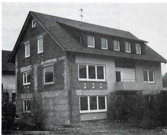
Bild 9. Dasselbe Gebäude (Bild 8) nach der Reparatur.
