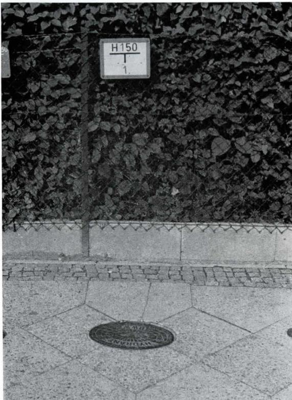
Bild 5. Unterflurhydranten-Beschilderung an einer Straßenfront. Untere Ziffer sagt die Entfernung von der Baufluchtlinie, obere den Rohrquerschnitt der Hauptwasserleitung.
