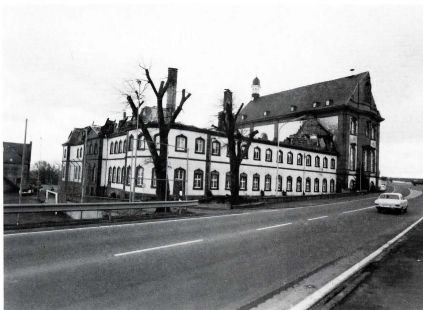
Bild 3. Das Helenenstift bei Trier nach dem Brand vom 13. 12. 1980. Auch hier ist deutlich das Fehlen von Brandabschnitten festzustellen.
