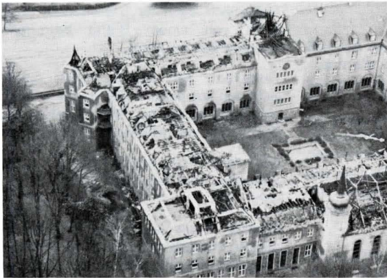
Bild 1. Die ungehinderte Ausbreitung des Feuers im Dachstuhlbereich ist deutlich zu erkennen.
