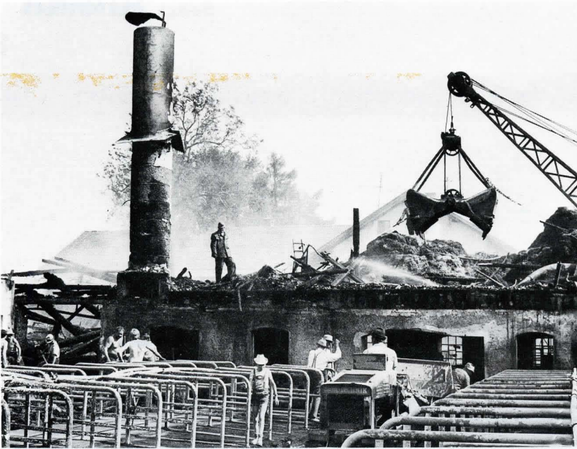
Bild 2. Die Gesamtübersicht über das Schadenobjekt.
