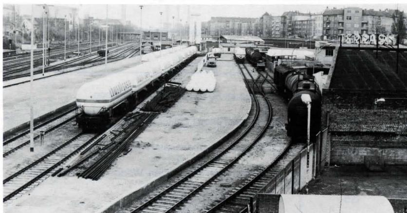
Bild 4. Ansicht eines Güterbahnhofes mit Flüssiggasanlage. Man beachte die großen Kesselwagenansammlung (20 x 90 m<sup>3</sup>).
