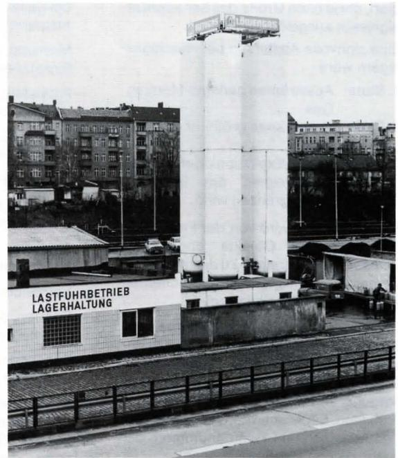
Bild 5. Beispiel eines Flüssiggaslagers in einer Großstadt. Die Wohnhäuser stehen in unmittelbarer Nähe.
