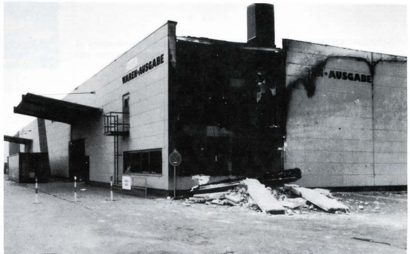
Bild 1. Ansicht der beschädigten Halle
