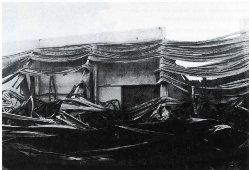
Bild 3. Brandverhalten von ungeschützten Stahlteilen, Brandschutztor geschlossen, Brandwand über Dach geführt.
