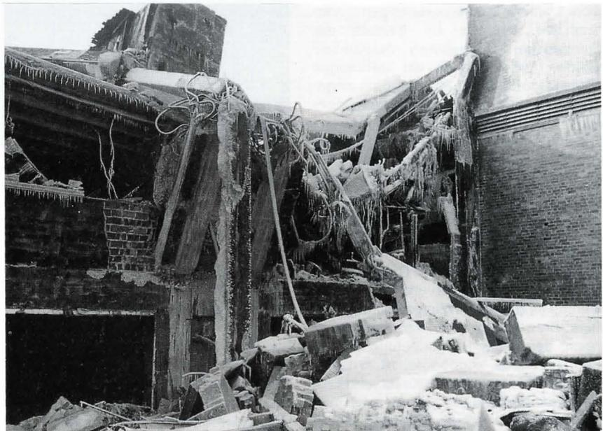
Die abstürzenden Stahlbetonträger knickten die Stützen in der Außenwand teilweise nach außen und im oberen Bereich zum Gebäudeinnern hin.
