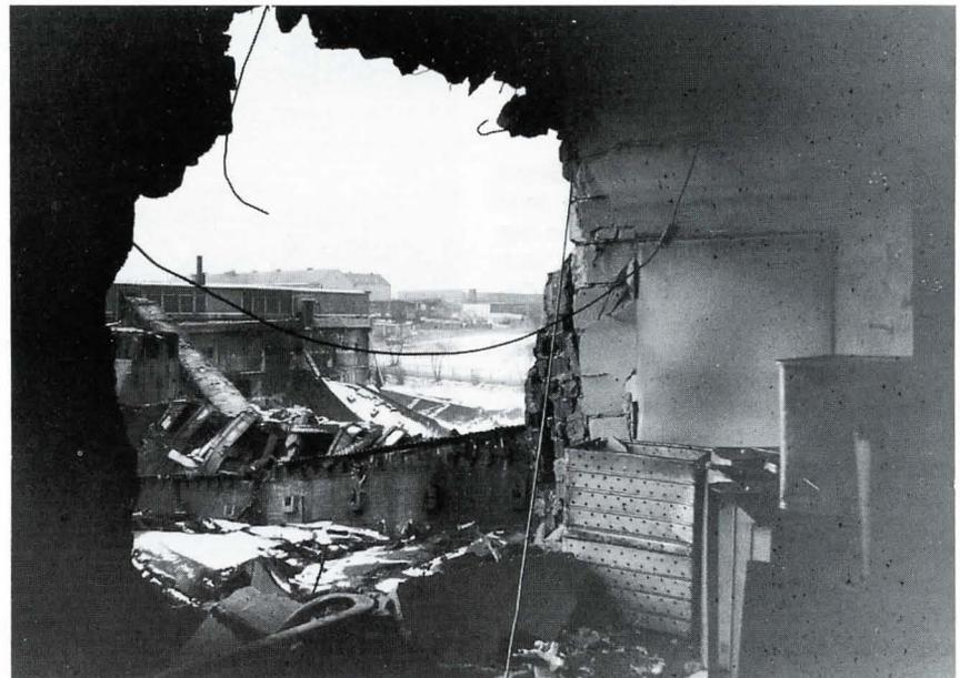
Die abstürzenden Stahlbetonträger über der Halle rissen große Löcher in die Brandwände zwischen den Anbauten und der Fabrikhalle.
