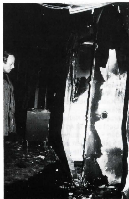
Bild 3. Sogar die abgehängte Decke wurde beschädigt.
