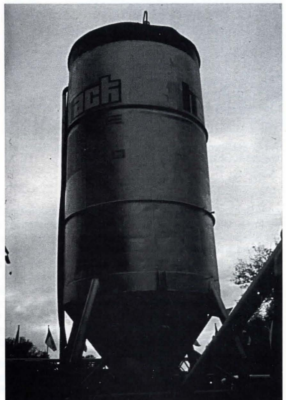
Bild 1. Zementsilo Beschädigung durch Abreißen des Deckels a. d. Oberkante erkennbar.
