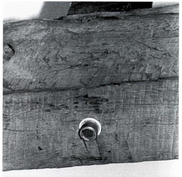
Bild 6. Im Balken eingelassener Brandmelder.
