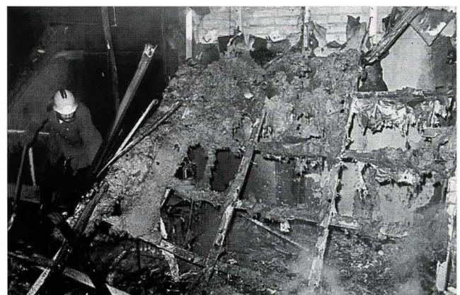
Bild 6 Ansicht einer Leichtbaudecke mit aufgelegtem und zusammengeschmolzenem Isoliermaterial, das während des Brandes brennend abtropfte.
