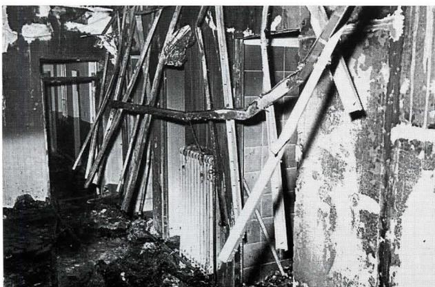
Bild 5 Heruntergefallene abgehängte Leichtbaudecke.
