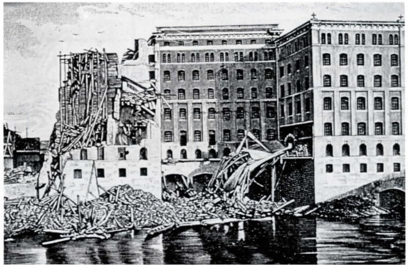
Bild 3. Staubexplosionen haben schon im vorigen Jahrhundert zu schweren Zerstörungen von Gebäuden und Anlagen geführt. Das Bild zeigt die Neue Wesermühle zu Hameln nach der Getreidestaubexplosion im Jahre 1887 [7].
