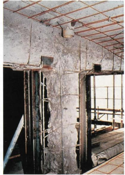
Bild 9. Brandschaden der Schadenklasse V an einer Stahlbetonstütze.
