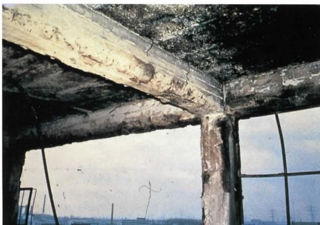
Bild 4. Brandschaden der Schadenklasse II (Stütze) und III (Unterzug) in einem Stahlbetonbauwerk
