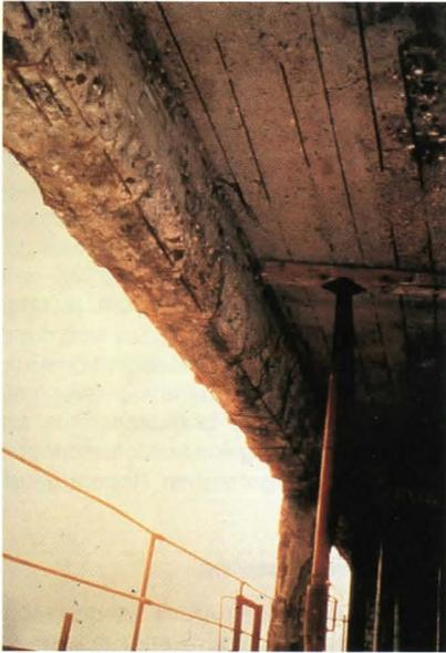
Bild 5. Brandschaden der Schadenklasse III an einem Stahlbetonunterzug.
