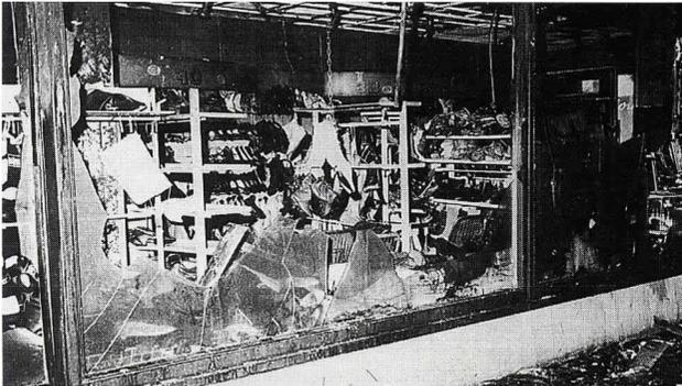
Abb. 2. Brand des Tegel-Centers in Berlin. Rauch- und Wärmeschäden in einer in großer Entfernung vom Brandort gelegenen Nutzungseinheit. Foto: Berliner Feuerwehr
