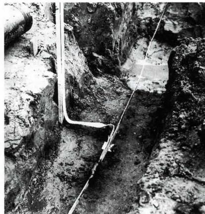
Bild 5: Fundamenterder mit Erdungsleitung zur Potentialausgleichschiene.
