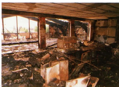
Die Sichtöffnungen in der Trennwand zwischen Gaststätte und Tennishalle waren nicht mit Brandschutzverglasungen gesichert. Die vorhandene Verglasung versagte nach kurzer Zeit und das Feuer konnte auf die Halle übergreifen. Im Hintergrund die zerstörte Verglasung der Squash-Halle.
