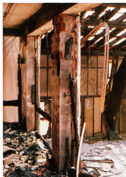
Die Sichtöffnungen in der Trennwand zwischen Gaststätte und Tennishalle waren nicht mit Brandschutzverglasungen gesichert. Die vorhandene Verglasung versagte nach kurzer Zeit und das Feuer konnte auf die Halle übergreifen. Im Hintergrund die zerstörte Verglasung der Squash-Halle.
