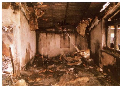
Das Feuer brach in der Sauna im ausgebauten DG aus. Die Sauna verbrannte vollständig. Rechts die Fassade mit Fenster. Links der Ruheraum mit Solarium und anschließender Trennwand zur Tennishalle.
