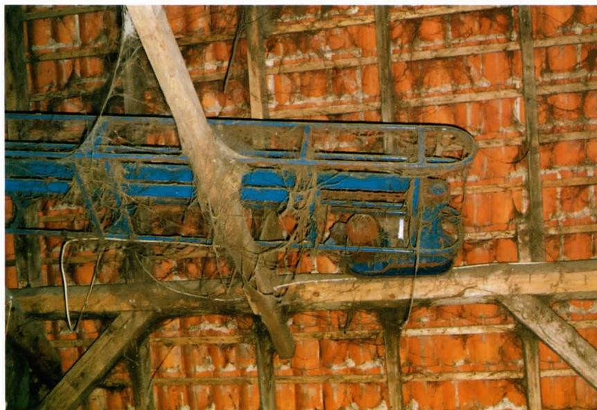
*Staubfäden und Spinnweben am Elektromotor des Höhenförderers: Akute Brandgefahr!*
