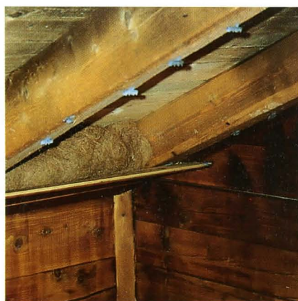
Bild 4: Ein kleiner Rest der Kokosisolierung blieb erhalten. Hier ist ersichtlich, wie die Kokosfasermatte zwischen Dachschalung und Profilholzverkleidung eingeschoben war.
