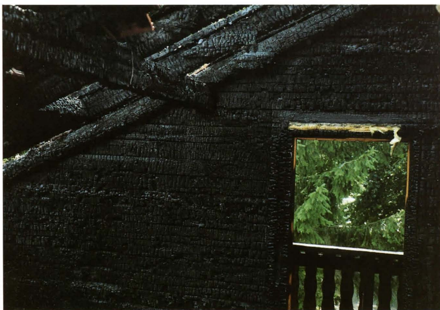
Bild 3: Die Giebelwand von innen.
