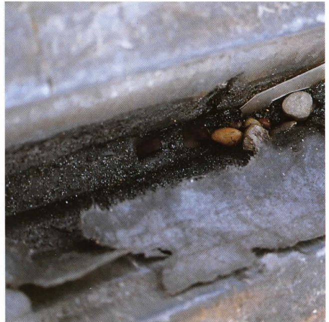
Bild 10 und 11: Das brennbare Gasgemisch gelangte durch verschiedene Öffnungen wie z. B. den Längs- und Querstößen der Trapezbleche oder Bohrlöcher in den Deckenhohlraum zwischen untergehängter Decke und Trapezblechprofilen.
