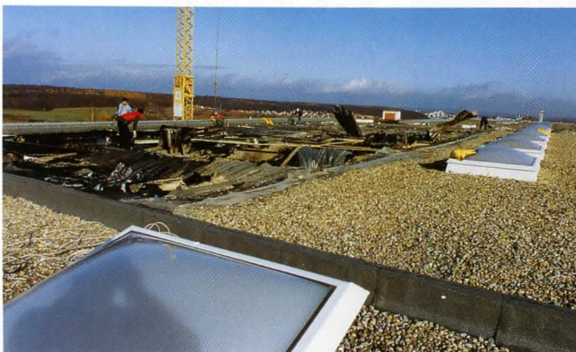
Bild 3: Dach der schadenbetroffenen Halle (Computer) von Süden aus gesehen. Der freie Streifen (mit Abdichtung ohne Bekiesung) zeigt die Trennung zwischen der Metallverarbeitung und dem Computerverkauf. Trennung durch zweischalige Wand aus Kalksandsteinmauerwerk, bis dicht unter die Dachhaut geführt.
