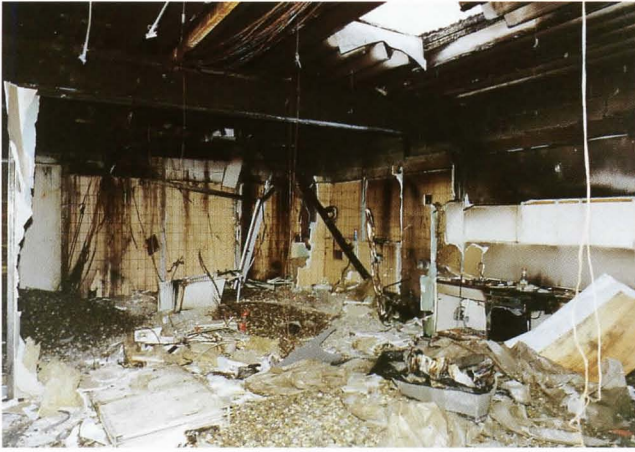
Bild 16: Situation aus Bild 15. Übersicht nach Entfernen der WC-Zwischenwände. Im Hintergrund die Trennwand zur angrenzenden Halle (Medizinische Geräte).
