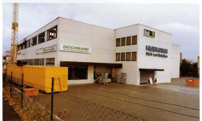
Bild 2: Ansicht von Süden
