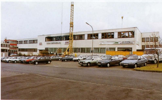
Bild 1: Ansicht von Westen
