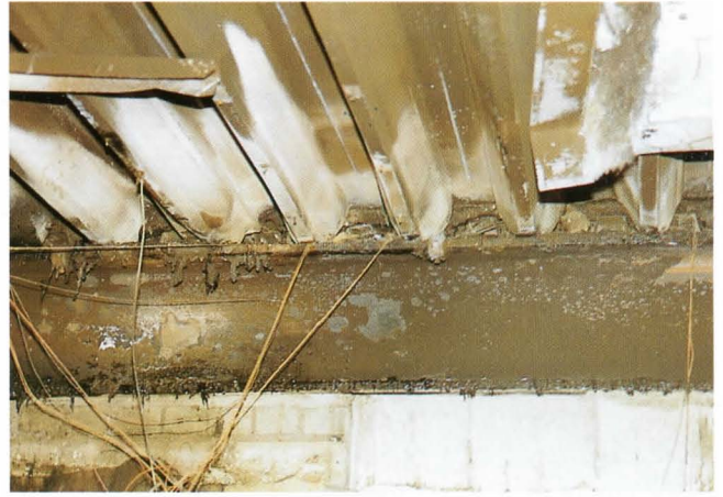
Bild 17: Detail aus Bild 16. Diese Wand wurde bis dicht unter einen Stahlträger geführt. Die Trapezbleche liegen auf dem Stahlträger auf und laufen durch. Deutlich zu sehen ist die Sickenabdichtung an der Unterseite mit Mineralfaser.
