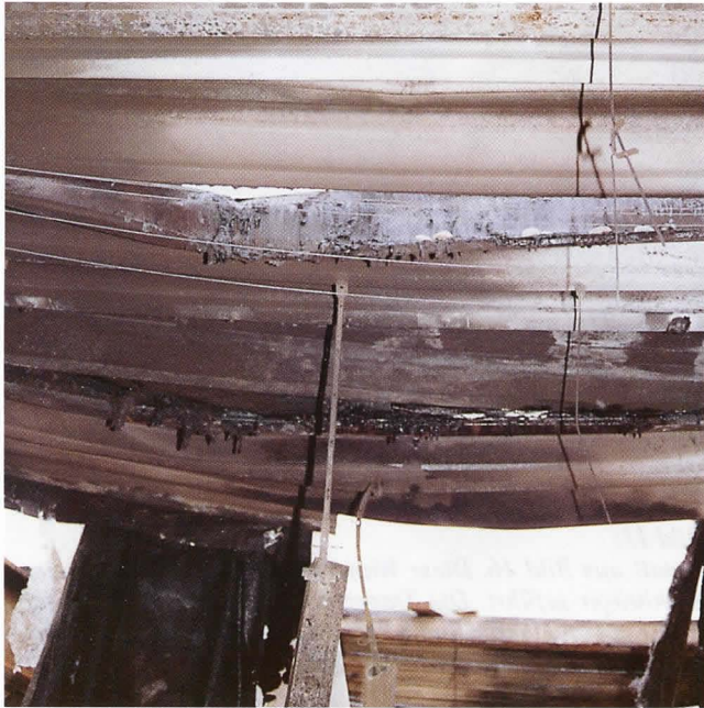
Bild 10 und 11: Das brennbare Gasgemisch gelangte durch verschiedene Öffnungen wie z. B. den Längs- und Querstößen der Trapezbleche oder Bohrlöcher in den Deckenhohlraum zwischen untergehängter Decke und Trapezblechprofilen.
