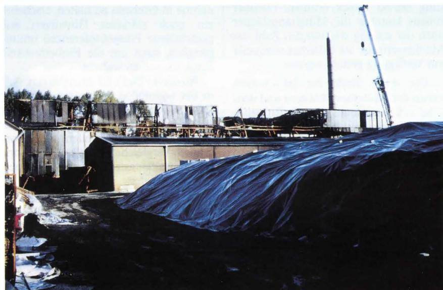
*Bild 6 und 7: Das Brandgut wurde nach dem Umsetzen mit schwerer Technik zum Ablöschen mit einer ca. 1 m hohen Sandschicht und teilweise mit Folien abgedeckt.*
