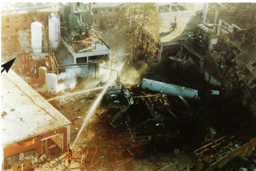
Abb. 3: Die Explosion führte auf dem Werksgelände zu schweren Zerstörungen und im Umkreis von bis zu 1000 m zu zahlreichen Gebäudeschäden.
